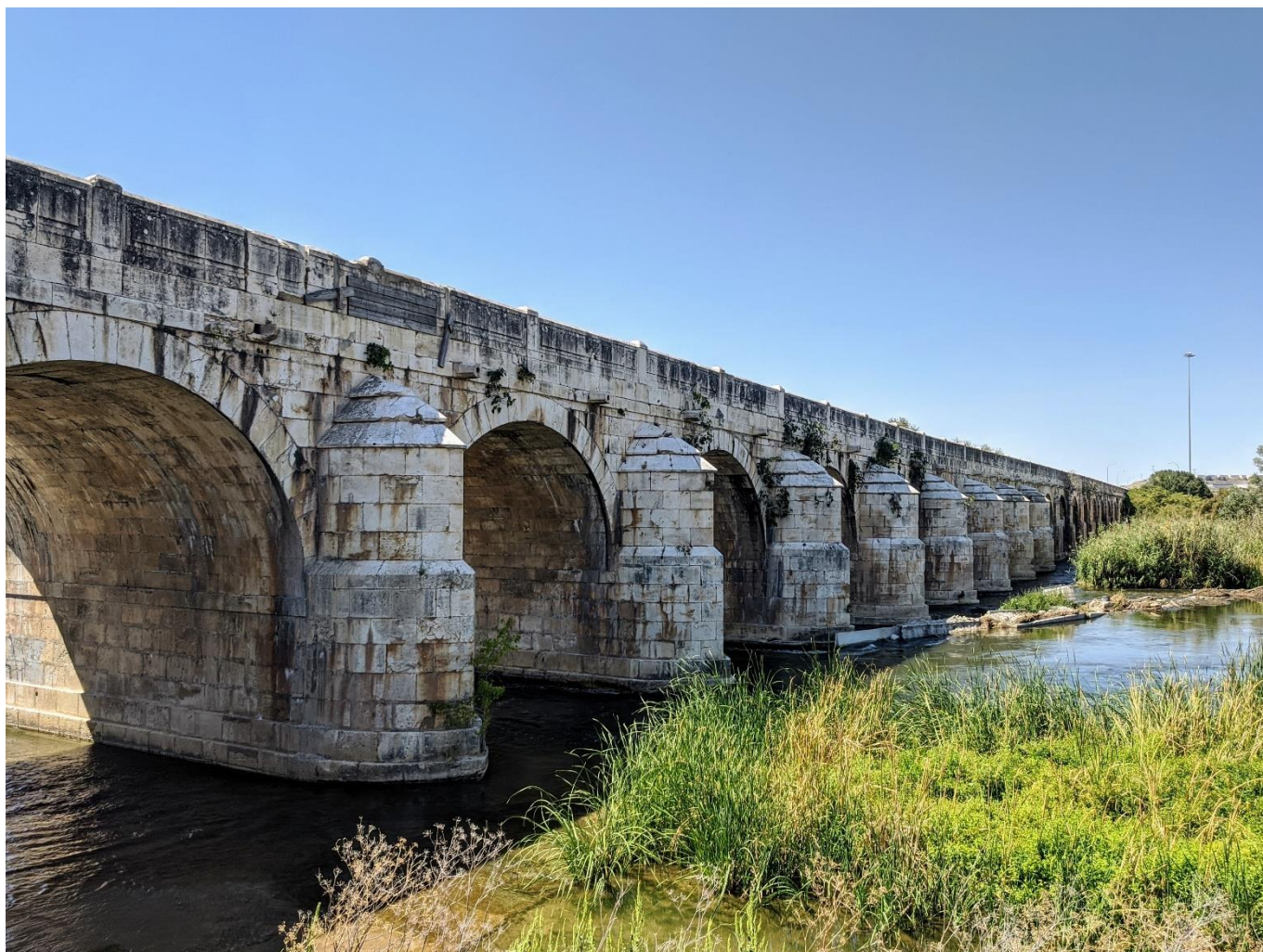
Río Jarama a su paso por Aranjuez. Puente Largo
